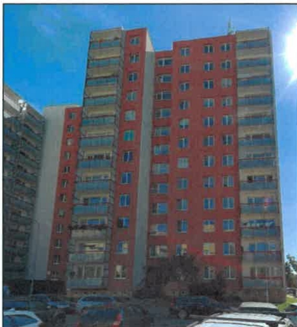
Foto 1 Pohled na bytový dům Mikulovská 4
