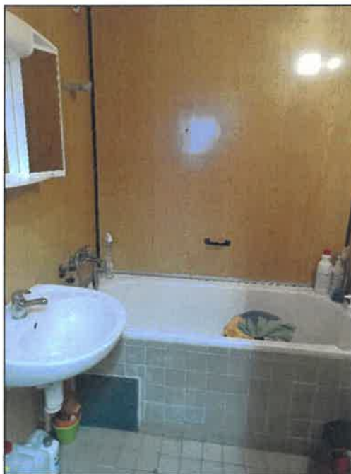
Foto 2 Pohled na koupelnu s vyměněným keramickým umyvadlem
