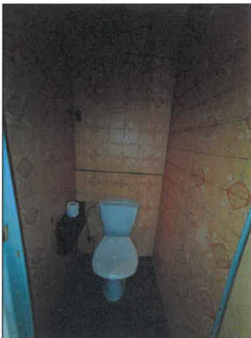
Foto 4 Standardní WC, umakartové konstrukce polepené tapetou
